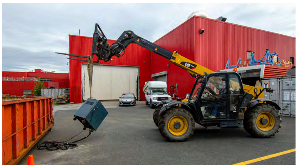
Au milieu : Ken Casey évalue la méthode la plus appropriée pour sortir le GPU sans causer de dommages. Ci-dessus : le GPU pesant assez lourd, les grands moyens sont pris pour l'extraitre de la benne en toute sécurité (photos Pierre Gillard).
