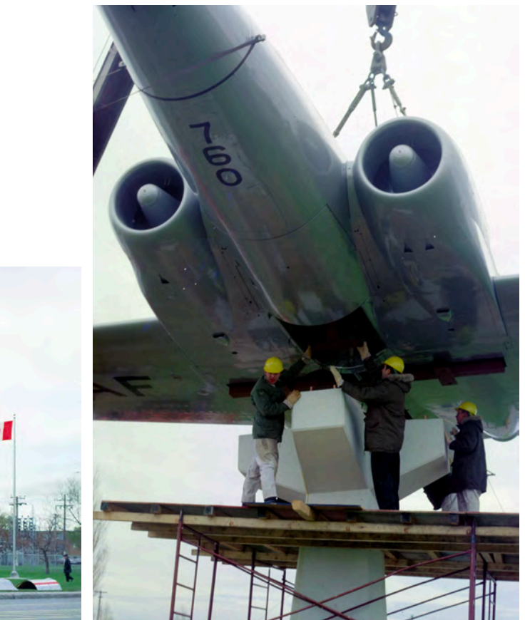
Quelques vues du transfert du CF-100 de la base militaire, où il a été préparé, vers le socle de béton destiné à le soutenir et l'installation de l'avion sur celui-ci (photos Robert St-Pierre).
