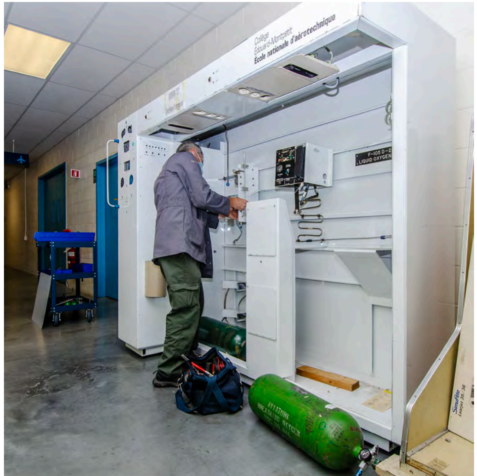
Frédéric Morin effectuant soigneusement le démontage des pièces et composants du panneau qui seront préservés pour de futures utilisations (photo Pierre Gillard).
