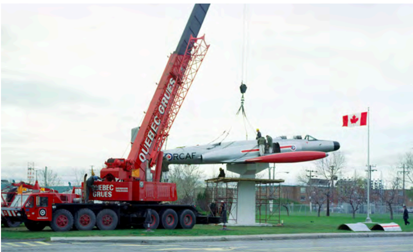
Quelques vues du transfert du CF-100 de la base militaire, où il a été préparé, vers le socle de béton destiné à le soutenir et l'installation de l'avion sur celui-ci (photos Robert St-Pierre).
