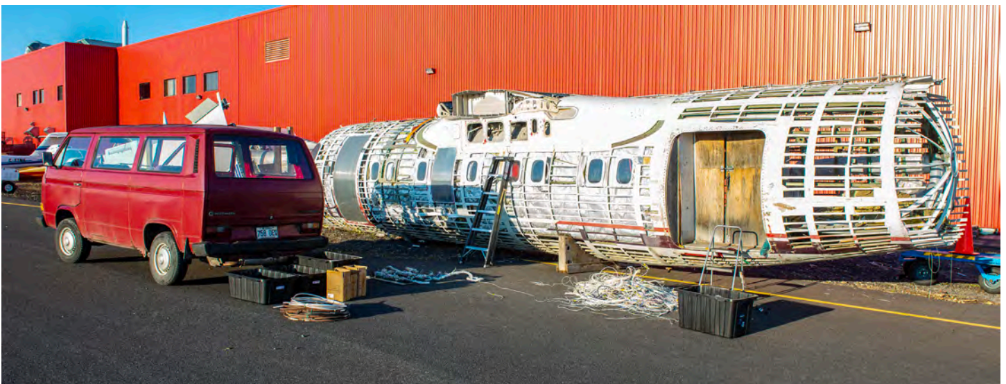
Le matériel et les composants sont directement triés une fois démontés et sortis du fuselage (photo Pierre Gillard).
